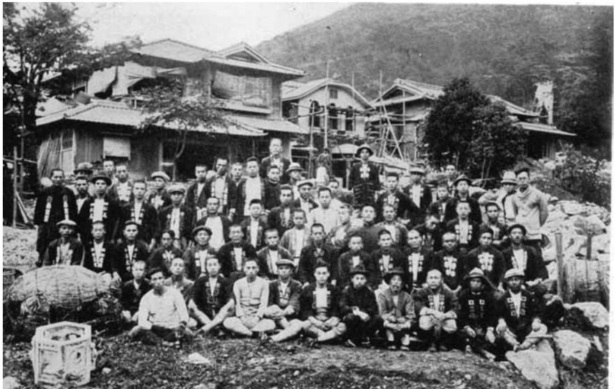
｜ 和中庵の建築工事（『藤井彦四郎傳』より）
